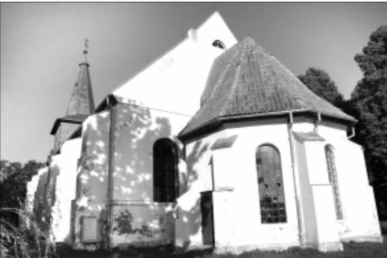
Rusnės evangelikų liuteronų bažnyčia su išdaužtais langais
